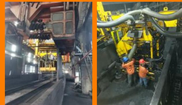
韶关中南钢铁项目
